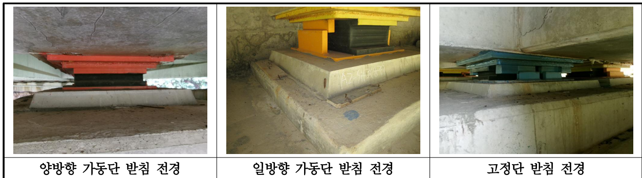
【사진 26.3.12】 교량받침 전경
