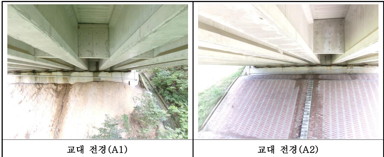
【사진 26.3.8】 교대 전경
