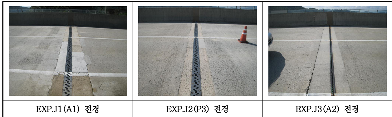
【사진 26.3.16】 신축이음장치 전경
