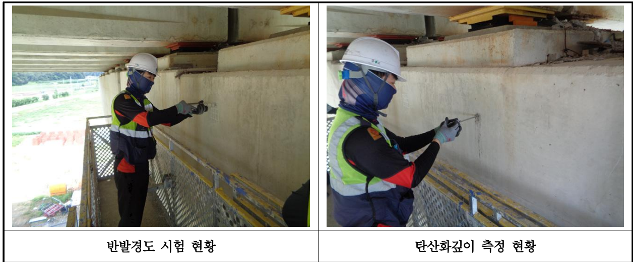
【사진 26.4.1】 콘크리트 내구성조사 현황
