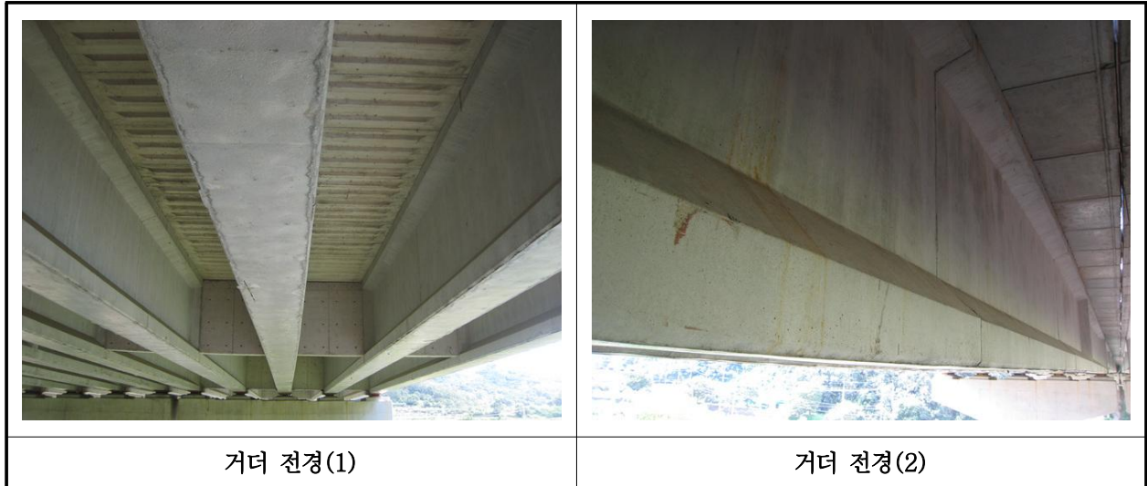
【사진 26.3.29】 거더 전경
