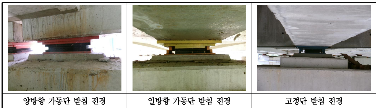
【사진 26.3.37】 교량받침 전경
