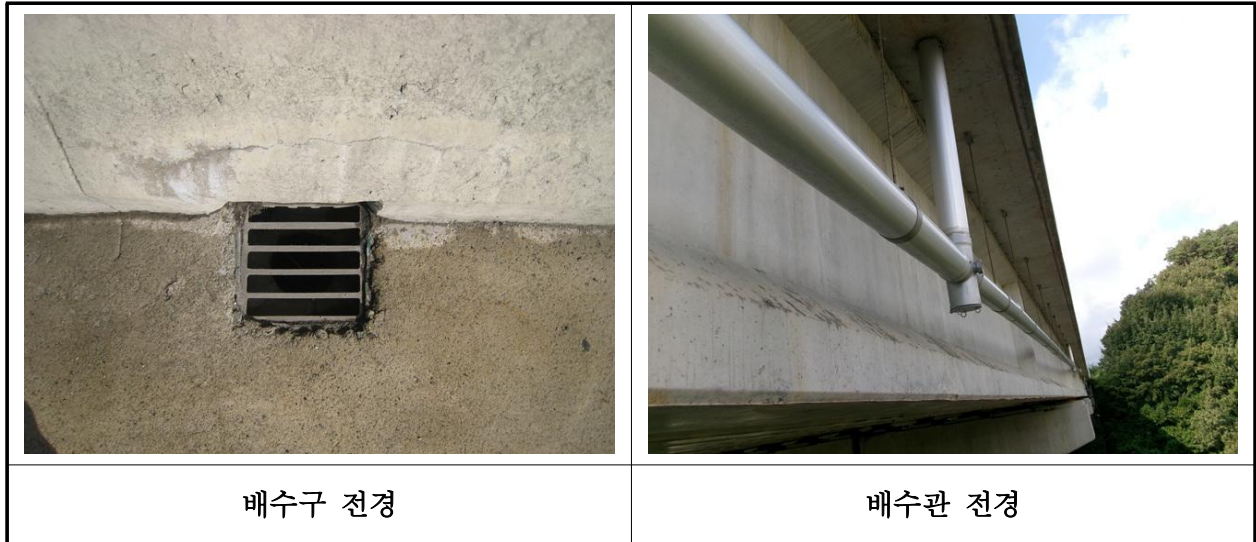
【사진 26.3.21】 배수시설 전경
