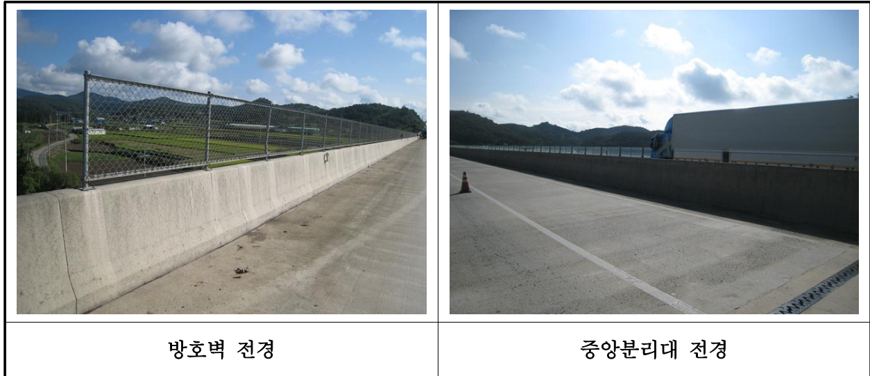
【사진 26.3.23】 방호벽 및 중앙분리대 전경
