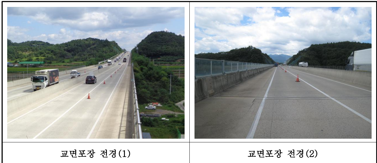
【사진 26.3.44】 교면포장 전경
