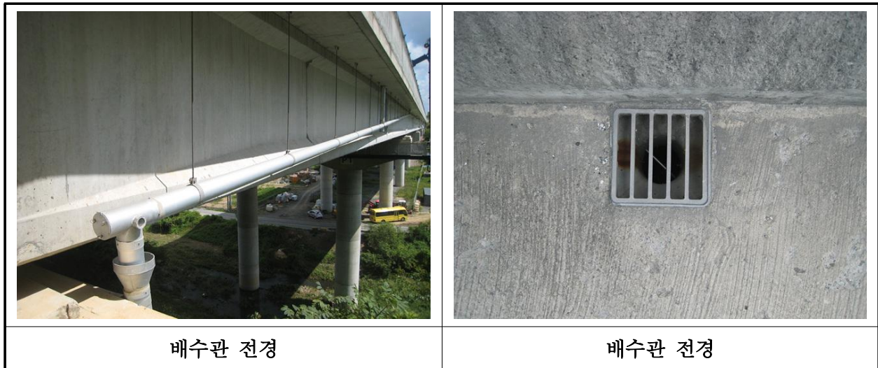
【사진 26.3.46】 배수시설 전경
