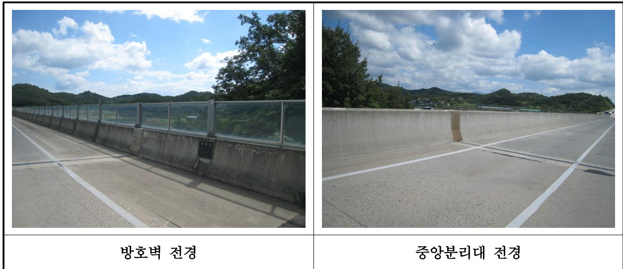
【사진 26.3.48】 방호벽 및 중앙분리대 전경
