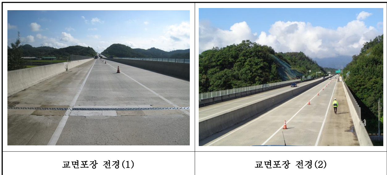
【사진 26.3.19】 교면포장 전경
