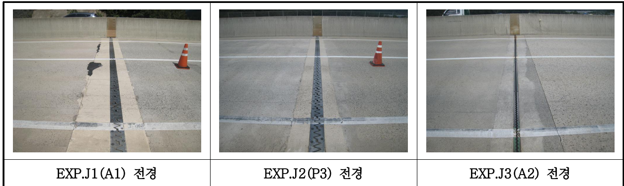
【사진 26.3.41】 신축이음장치 전경
